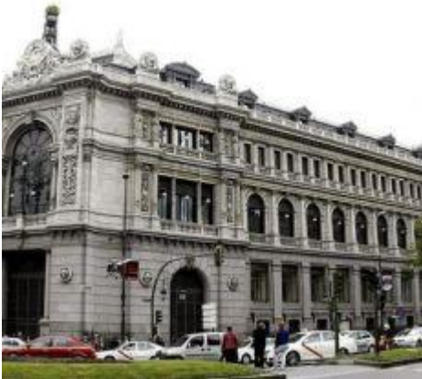
Fachada del Banco de España
